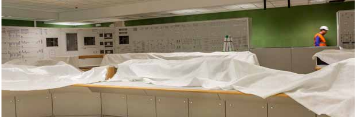
Panely počas inštalácie.
