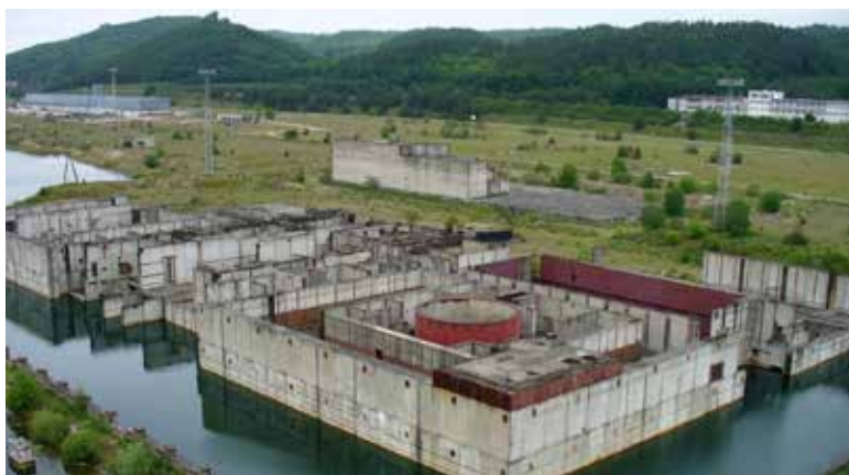
Pohľad na bloky VVER 440, ktorých výstavbu zastavili ešte v 80. rokoch.
