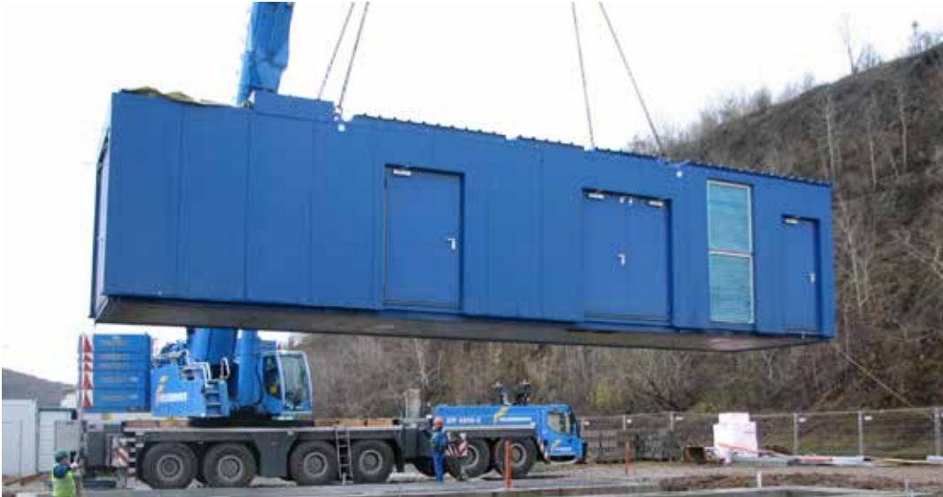
Ukladanie stanice s diesलगenerátorom pre ťažké havárie v EMO.
